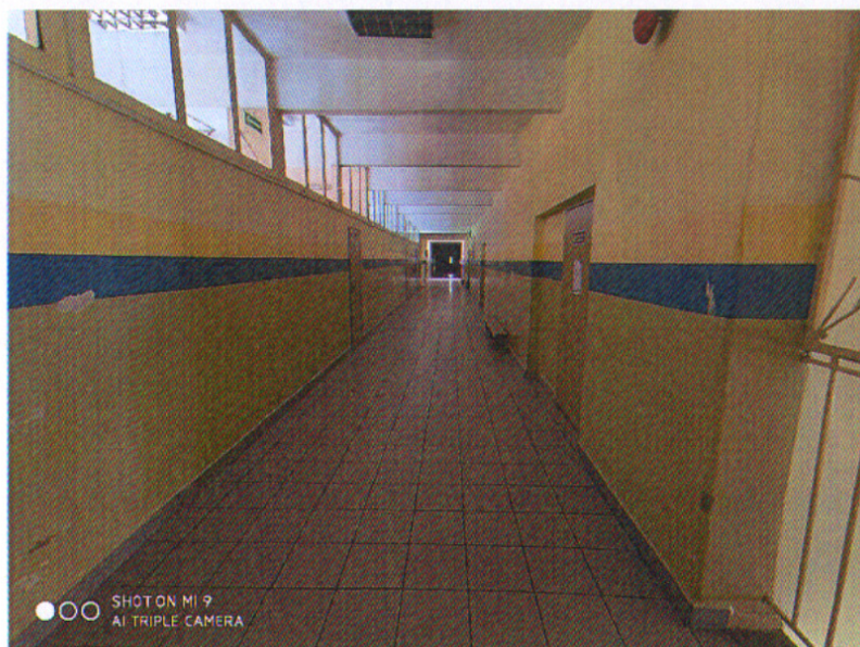
Zdj. Korytarze dłuższe niż 50 m bez zastosowania drzwi dymoszczelnych
