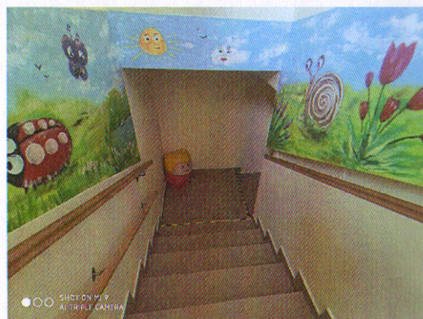
Zdj. Zaniżenie wysokości drogi ewakuacyjnej
